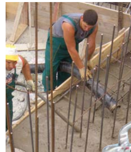
...ou pour le pompage de béton fin jusqu'à 16 mm. Grâce à l'anneau d'étanchéité à rattrapage de jeu automatique vous pouvez même l'utiliser pour de la chape fluide (photo à droite).
